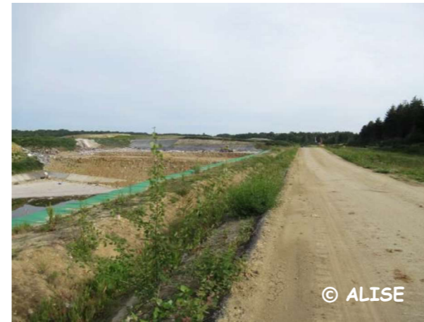
Photo 12 : Routes, chemins ou zone bitumées
